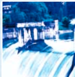
Bei Hochwasser werden die Wehrfelder automatisch geöffnet.
