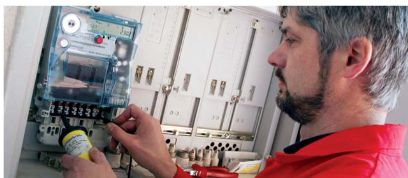
Mit wenigen Handgriffen hat Horst Baumgartner den alten Ferraris-Zähler ausgebaut und durch einen neuen, digitalen Zähler ersetzt.
